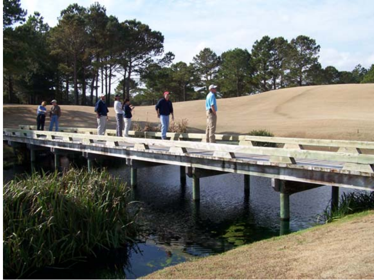
Plate 4. Sampling site on pond on par 3 course EP-POND3, from bridge.
